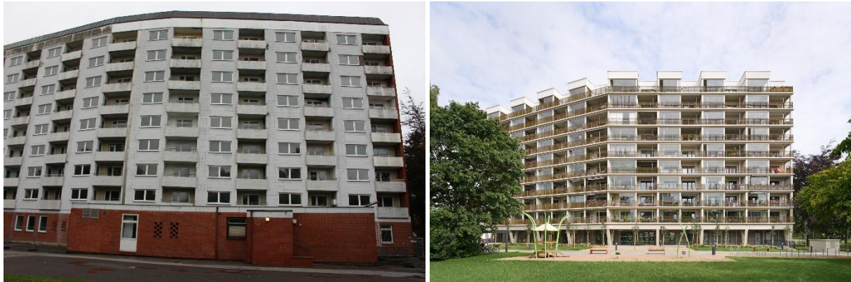
Hochhaus Sterntalerweg vor und nach der Sanierung © vorher: ppp / nachher: Stephan Baumann, bild_raum
