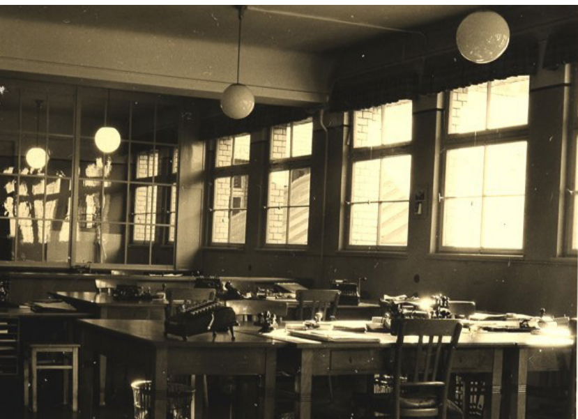
Kontorraum mit Glasdachflächen im Außenbereich 1937. Quelle: Fotoarchiv Jürgen Stein
