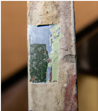
Sondierung Treppengeländer 2023. Quelle: Gunda Drephal
