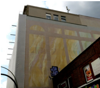
Fassadenmalerei 2023. Quelle: Gunda Drephal
