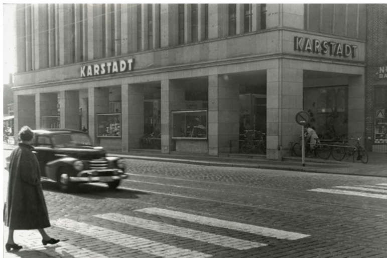
Veränderungen an der Fassade: Schaukästen und Absperrung in den offenen Stützen-zwischenräumen; Steinputz an den Giebelflächen. Quelle: Staatsarchiv Hamburg Signatur: 720-1_344-28=51963
